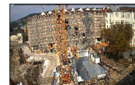
Kammgarn West inkl. Platz und Tiefgarage
