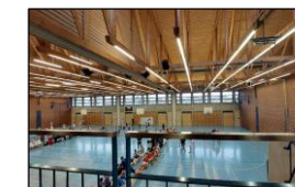
Sanierung Dreifachturnhalle Breite
