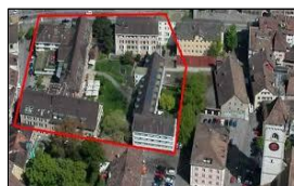
Sanierung Alterszentrum Kirchhofplatz
