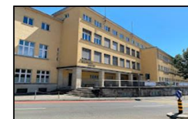
Sanierung Schulhaus GEGA
