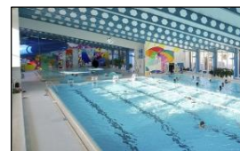
Neubau KSS Hallenbad
