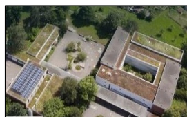
Sanierung & Erweiterung Schulzentrum Alpenblick
