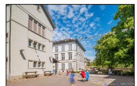
Sanierung Schulhaus Hemmental
