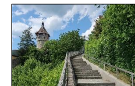
Römerstieg, Sanierung Mauer und Geländer
