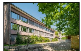
Sanierung Turnhalle Buchthalen
