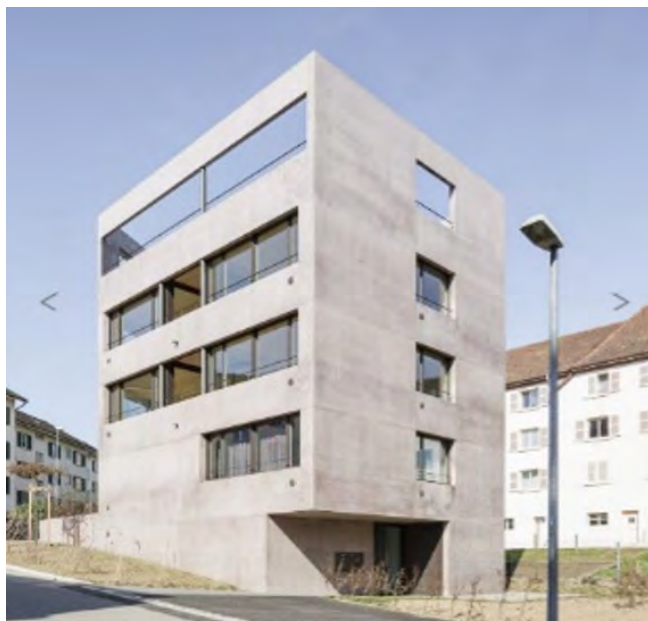
Abb. 23 Beispiel für Stadthäuser in Gruben (Foto: Silvano Pedrett, Quelle: Atelier Roland Hofer)
