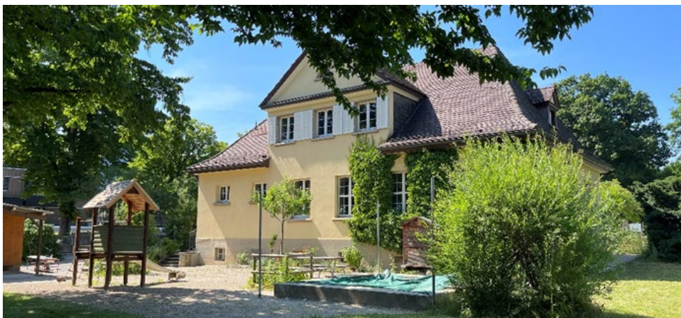
Abbildung 5: Südfassade Kindergarten Geissberg 2
