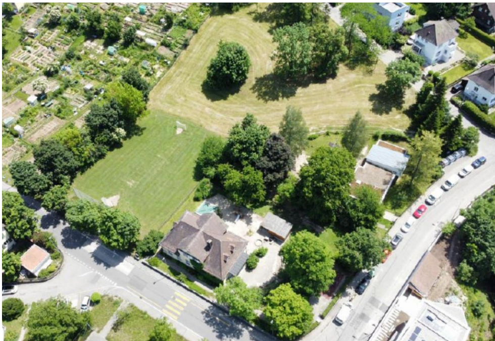
Abbildung 1: Luftbild Kindergartenareal Geissberg
