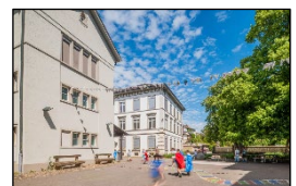
Sanierung Schulhaus Hemmental
