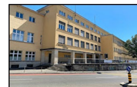
Sanierung Schulhaus GEGA
