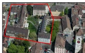
Sanierung Alterszentrum Kirchhofplatz
