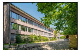
Sanierung Turnhalle Buchthalen
