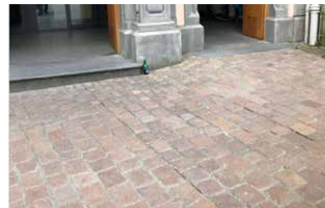
Abb. 8 – Bsp. gute barrierefreie Anpassung an erhöhten Hauseingang (Quelle: Pro Infirmis 2024)
