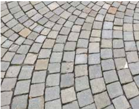
Abb. 80 – Pflasterung ungebunden (Foto: Stadtplanung SH 2025)
