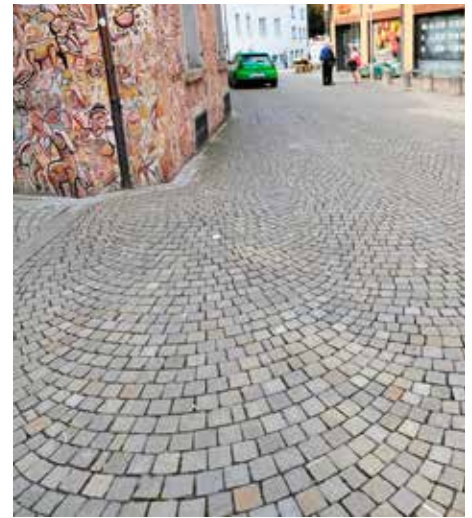
Abb. 23 – Bogenpflasterung offen verfugt, Altdorf (Foto Stadtplanung SH 2025)
