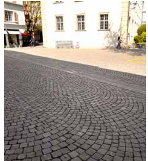
Abb. 24 – Aufweitung Gasse mit Bogenpflasterung, Altstadt Luzern (Foto Uniola 2025)
