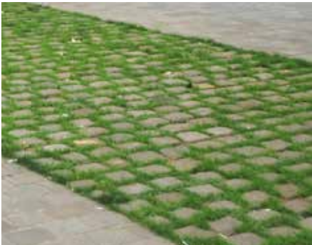
Abb. 78 – Pflasterung mit begrünten Fugen (Foto: Uniola 2020)
