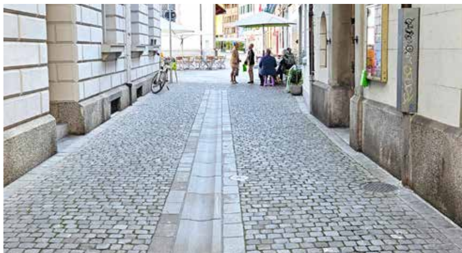
Abb. 36 – Reihenpflasterung offen verfügt, Bahnhofstrasse Luzern (Foto Uniola 2025)
