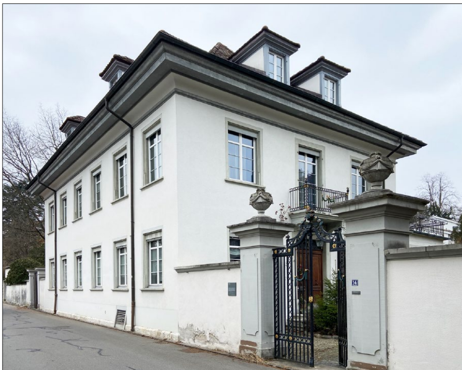
Abbildung 1: Ehemaliges Pfarrhaus «Generalengut» an der Stokarbergstrasse
