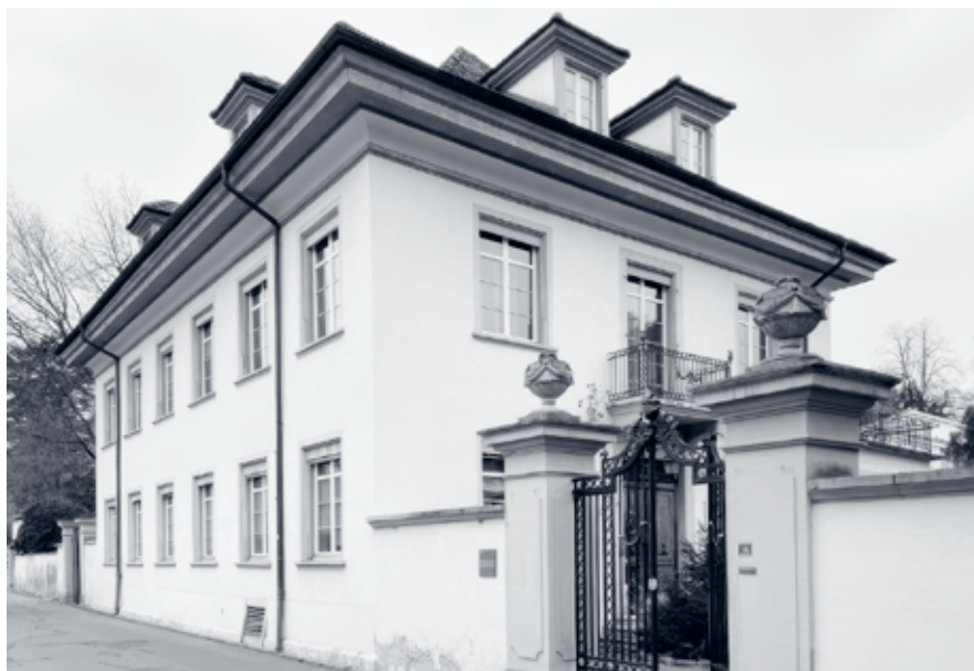
Ehemaliges Pfarrhaus «Generalengut» an der Stokarbergstrasse
