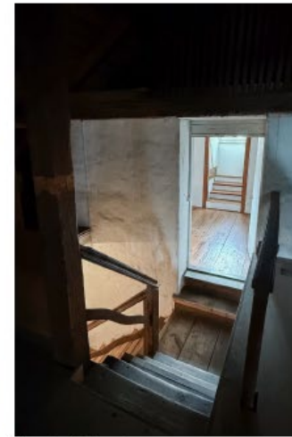
Treppe ins Dachgeschoss
