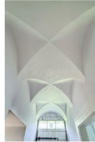
Kreuzgewölbe, Erdgeschoss
